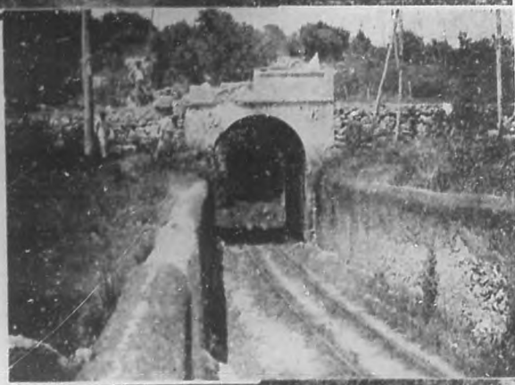
Entrada del túnel "Beola", que da acceso a la ciudad de Gibara por medio del ferrocarril.
