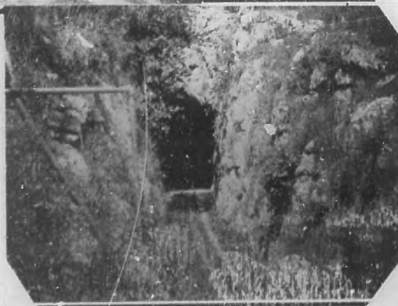
Interior del túnel donde se parapetaron los revolucionarios y desde el cual Laurent y Maderne hicieron fuego a los aviones del Gobierno.
